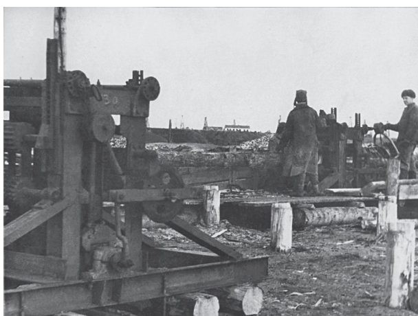
Лесопильный завод. Первая пиломатериала
