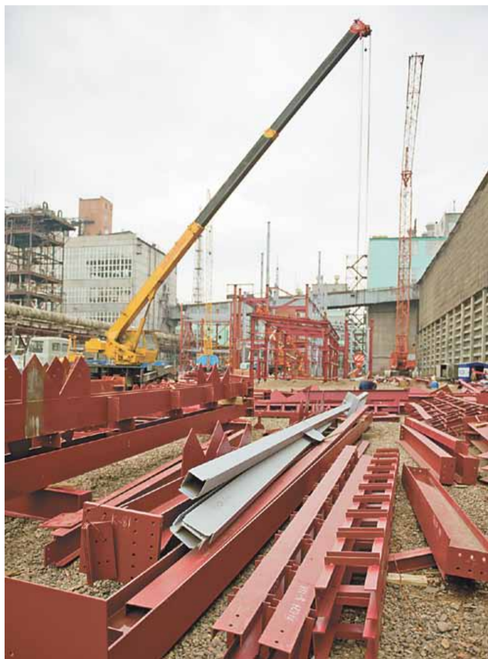
Установка карбамида: идет монтаж металлоконструкций
